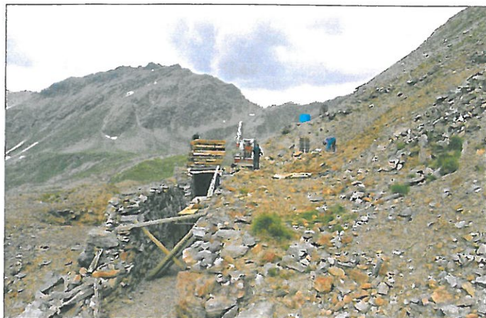
Schneekragen im Revier Himmelreich während der Restaurierung. Der vordere Bereich ist noch ohne Überdachung, hinten erkennt man bereits die Überdachung. Darüber liegt der Holzvorrat, der zur Fertigstellung der Überdachung des vorderen Bereichs dient. Foto: Heinz WIDMANN, aufgenommen im August 2013.
